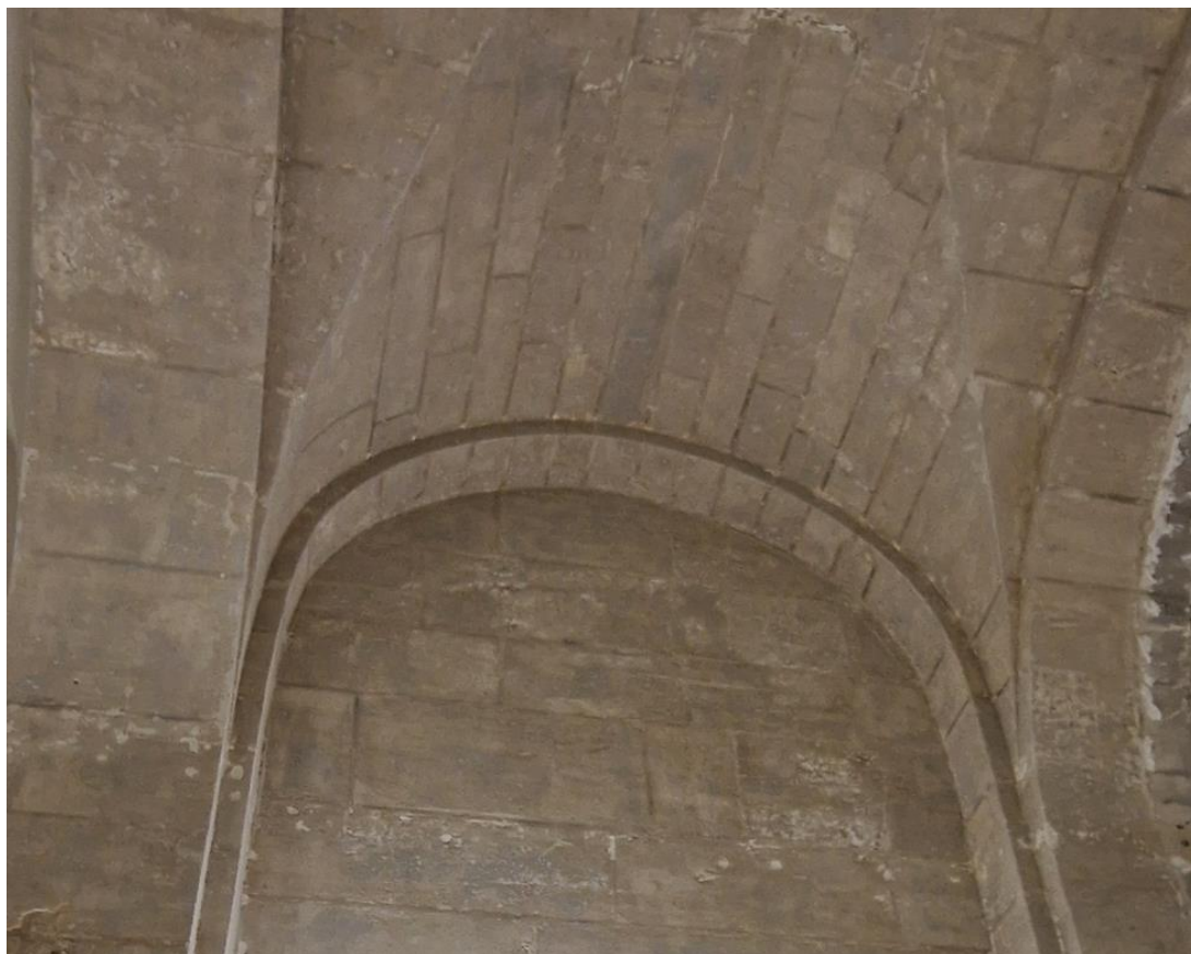
Exemple de surfaces conformes après déplombage
