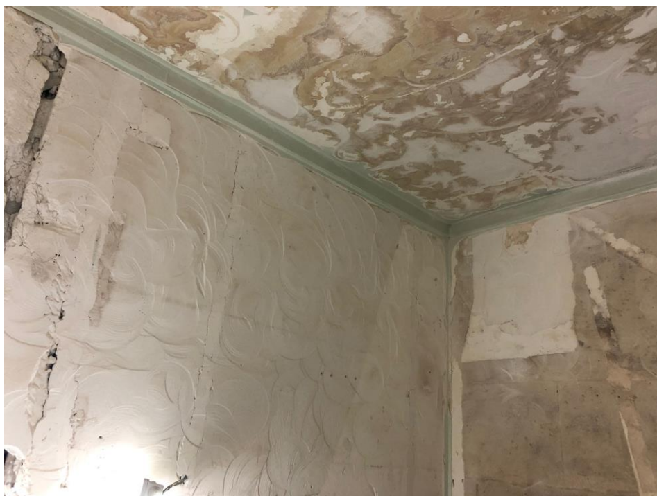
Exemple de surfaces non conformes avec traces préjudiciables de disques après déplombage
