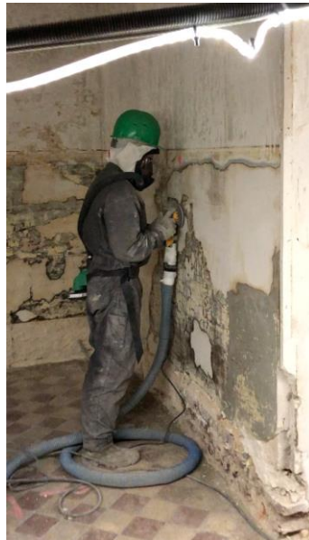
Exemple de ponceuses avec papier abrasif
